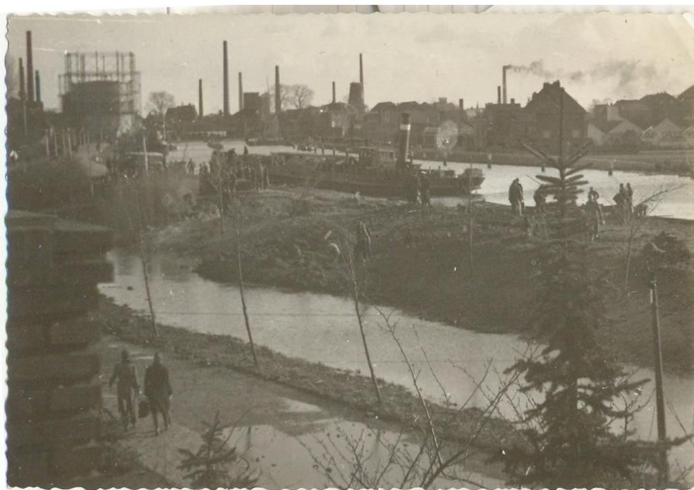
Over de Gouwe komt een boot aanvaren om de dijk te verstevigen. De dijk was toen nog veel lager en smaller dan nu. Langs de Gouwe liep een jaagpad om de boten te trekken.
