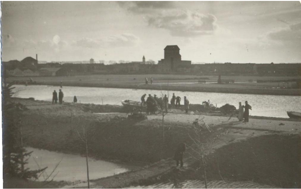
De mannen trekken het ponton tegen de dijk aan. Op de achtergrond "De Producent", die dan nog eenzaam vanuit de weilanden oprijst. De Betoncentrale is van latere tijden.
